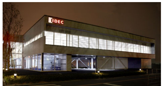
図 1 全館 LED 照明建屋の外観写真
