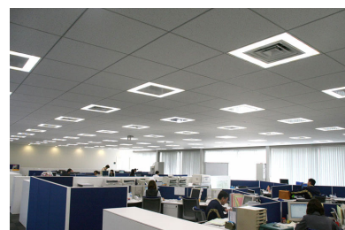
図2 2階オフィスのLED照明の様子
