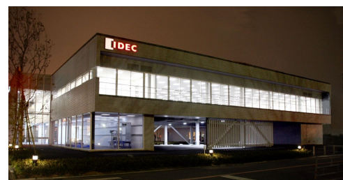
図1 全館LED照明の建屋の外観写真
