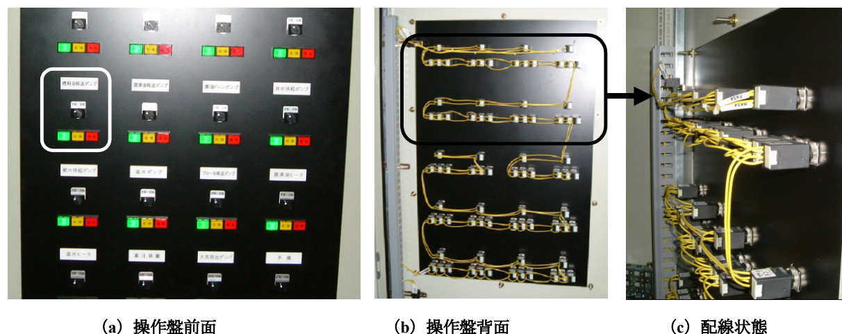
図 3 SwitchNet を用いた水処理施設の操作盤
