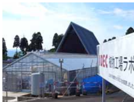
図 12. IDEC 植物工場ラボ外観
