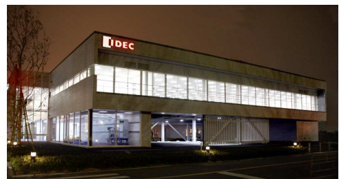
図 1 全館 LED 照明の建屋の外観写真 Fig.1 Photograph of all-LED
