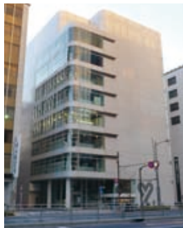
八重洲鹿島ビル (八重洲ブックセンター)
